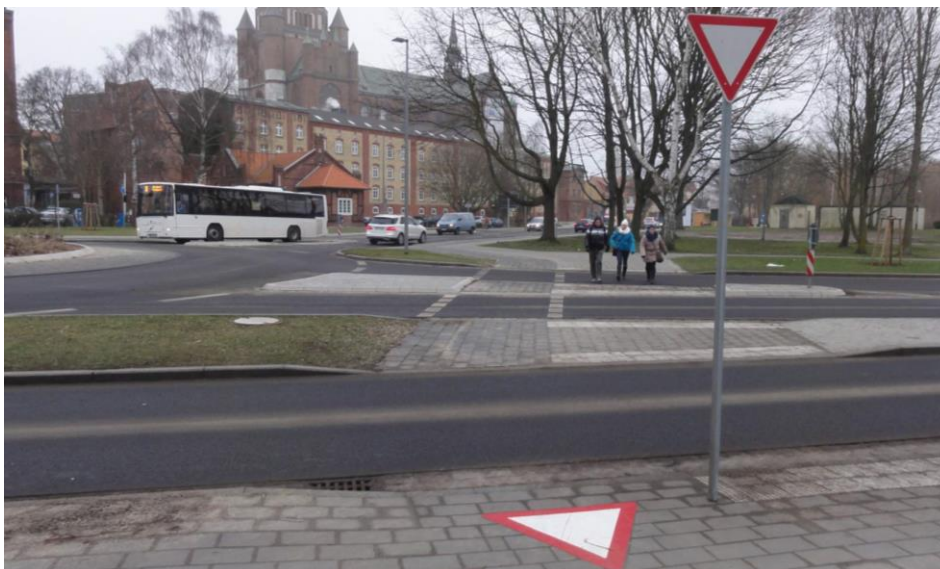
Foto: Gesonderter Hinweis für Radfahrer auf den bevorrechtigten Kfz-Verkehr am Bypass mittels Beschilderung/ Signatur am Boden
