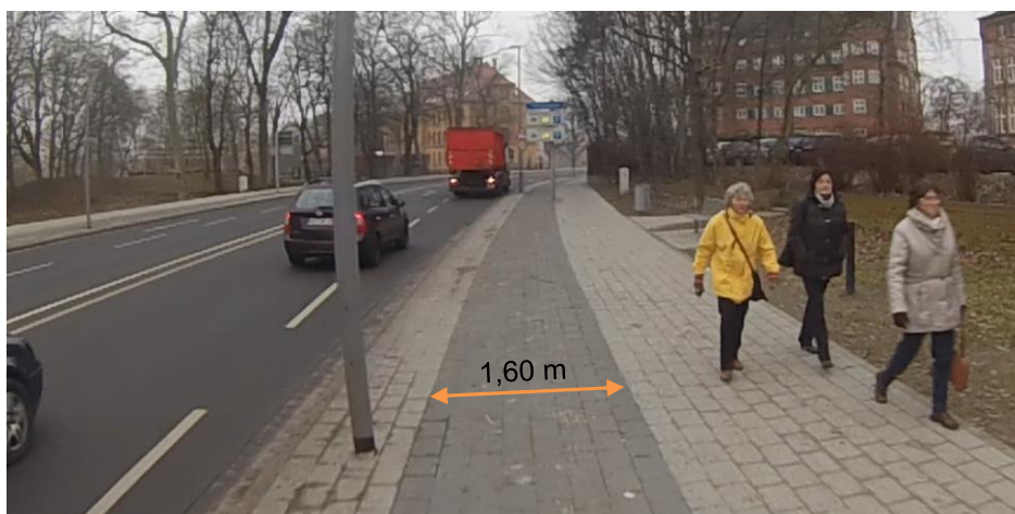
Foto: Beispiel für regelgerechte Anlagen gemäß ERA: Frankenwall zwischen Karl-Marx-Straße und Tribseer Damm, ausreichend dimensionierter „Getrennter Geh- und Radweg“
