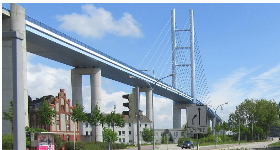
Foto: Blick auf den Pylon der Hochbrücke zwischen Festland und Rügen
