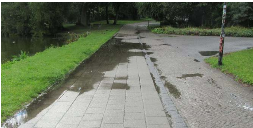
Foto: Große Pfütze im Bereich der Gehbahn auf dem Küterdamm (Ausweichen auf Radweg notwendig)
