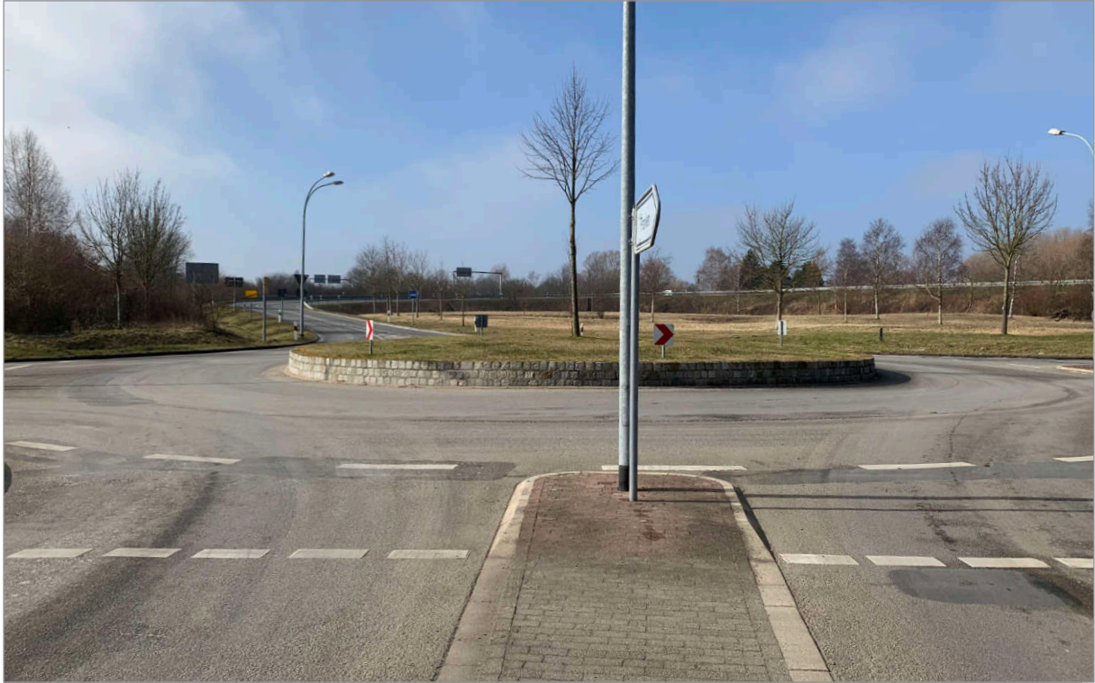
Abbildung 8 Kreisverkehr Ausfahrt B 96 / Feldstraße / Am Hohen Graben (eigene Aufnahme) | Blickrichtung Westen
