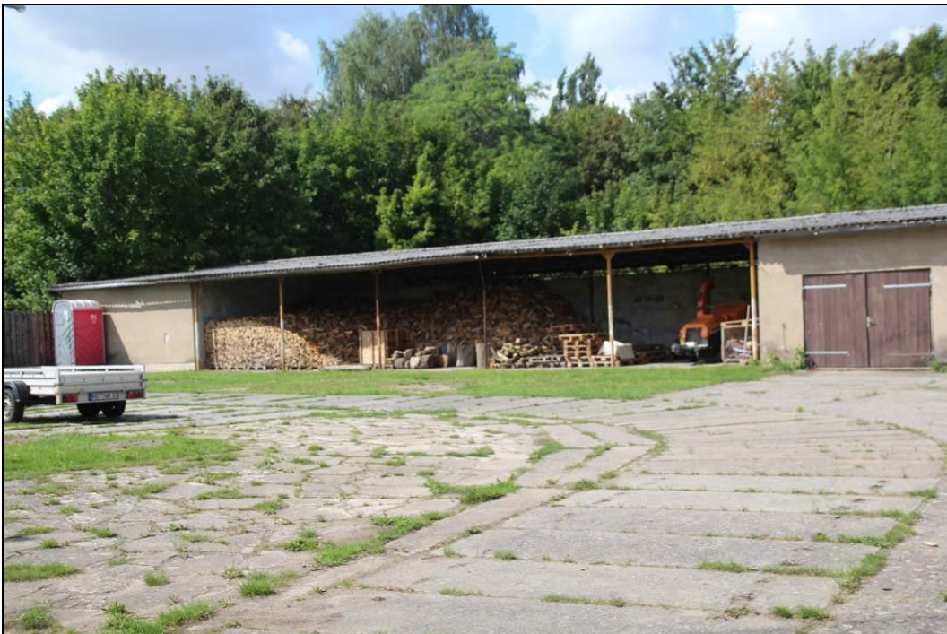
Abbildung 10: Noch teilweise bis Sommer 2020 genutzte Hallen des Gebäudes 2d.
