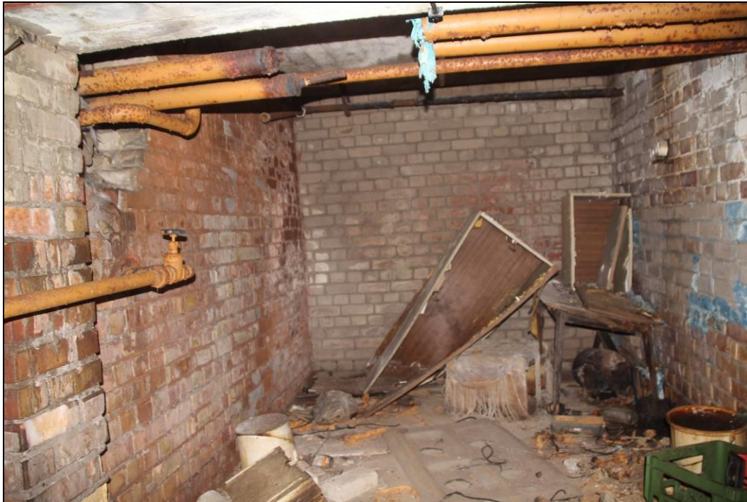
Abbildung 30: Raum im Keller südlich des alten Heizhauses der ehemaligen Gärtnerei (17. Februar 2021).
