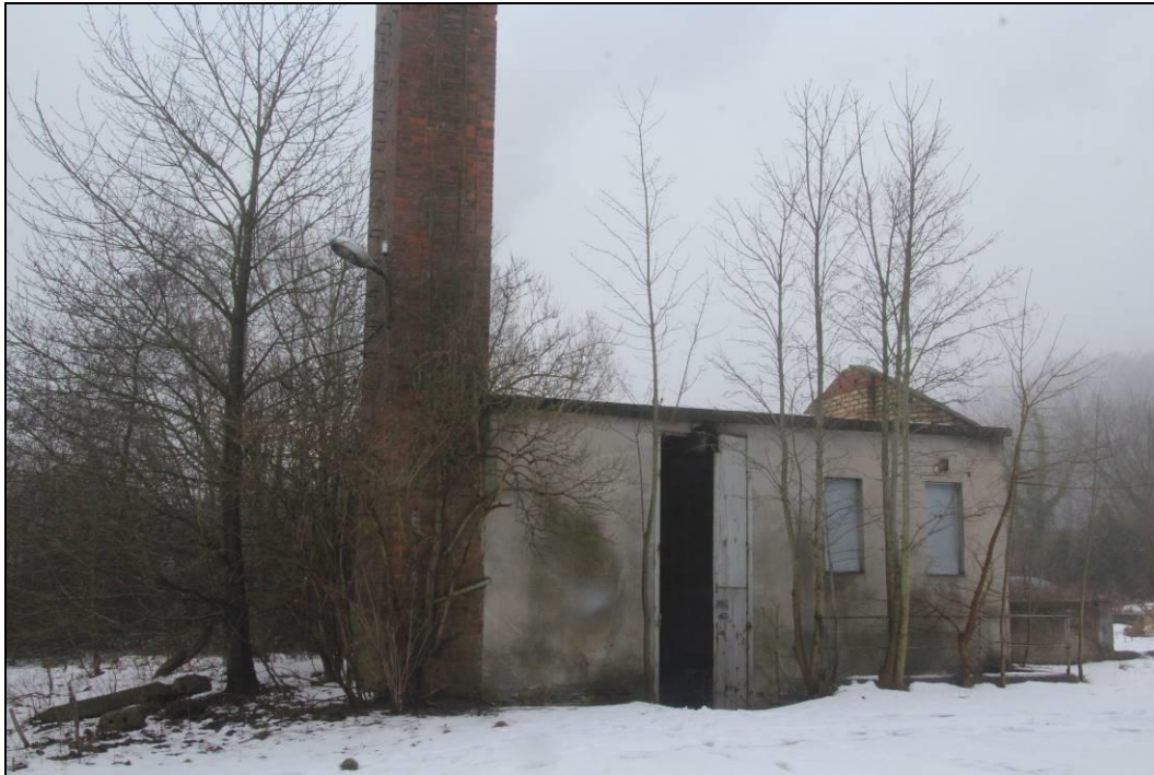
Abbildung 28: Oberirdischer Teil des alten Heizhauses der ehemaligen Gärtnerei (17. Februar 2021).
