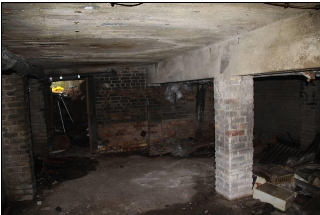
Abbildung 29: Keller südlich des alten Heizhauses der ehemaligen Gärtnerei (17. Februar 2021).
