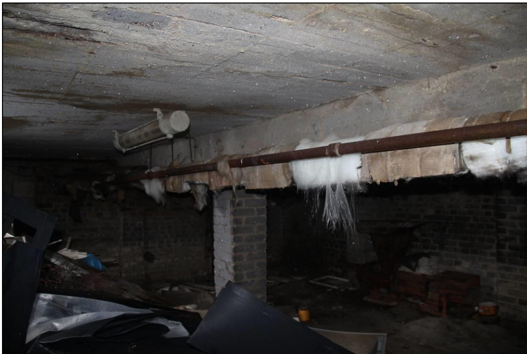
Abbildung 31: Raum im Keller südlich des alten Heizhauses der ehemaligen Gärtnerei (17. Februar 2021).
