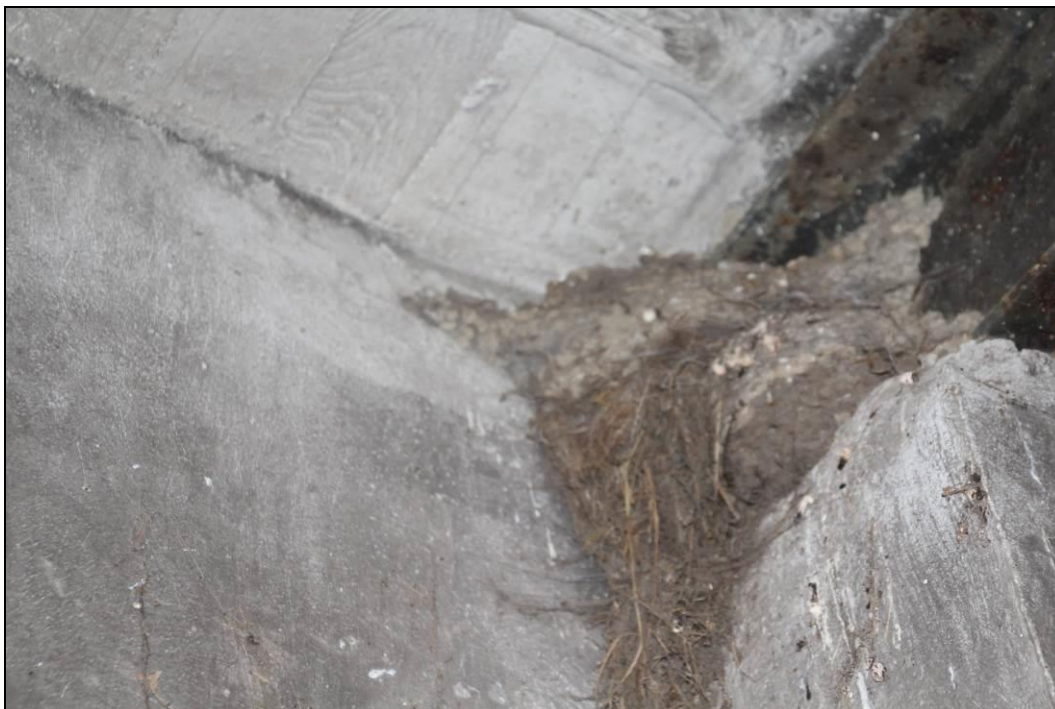
Abbildung 42: Rauchschwalbennest im alten Heizhaus der ehemaligen Gärtnerei (Gebäude 5).
