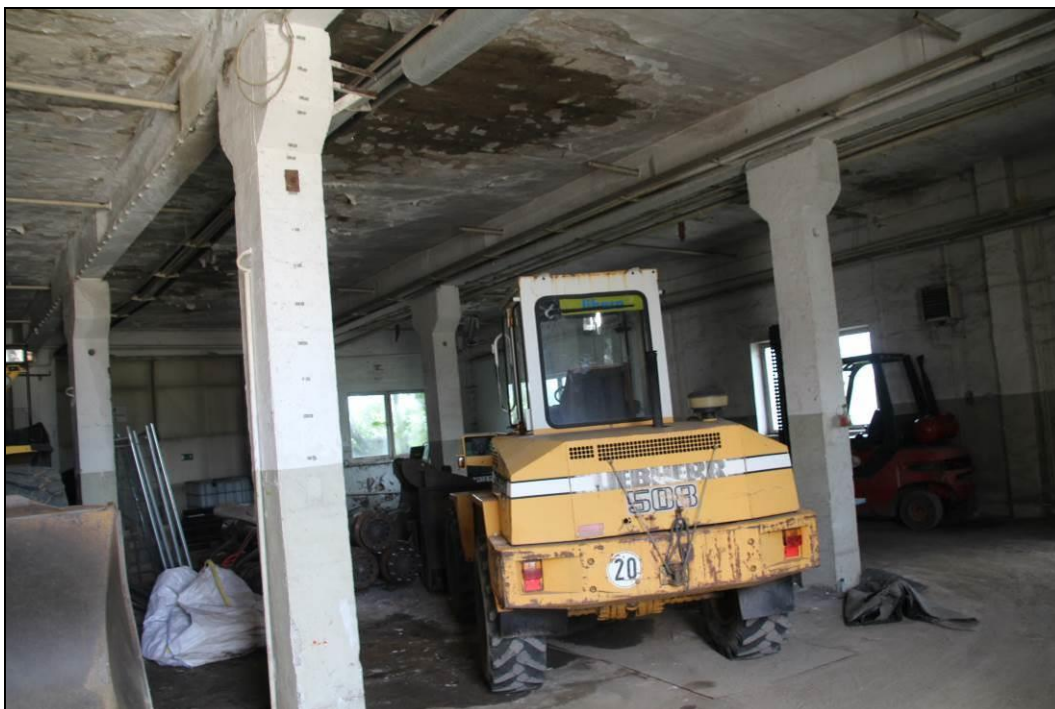
Abbildung 8: Aktuell als Garagen genutzte Räume im Erdgeschoss des Gebäudes 1c.
