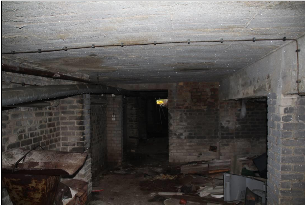
Abbildung 32: Raum im Keller südlich des alten Heizhauses der ehemaligen Gärtnerei (17. Februar 2021).
