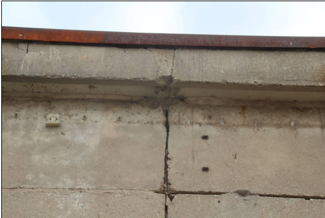
Abbildung 24: Im Dachbereich des Gebäudes 1a wurden keine Fledermäuse festgestellt.
