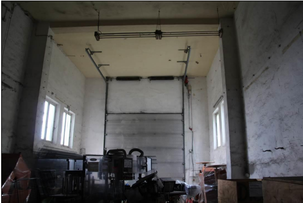
Abbildung 5: Als Lager genutzte Räume im Erdgeschoss des Gebäudes 1b.
