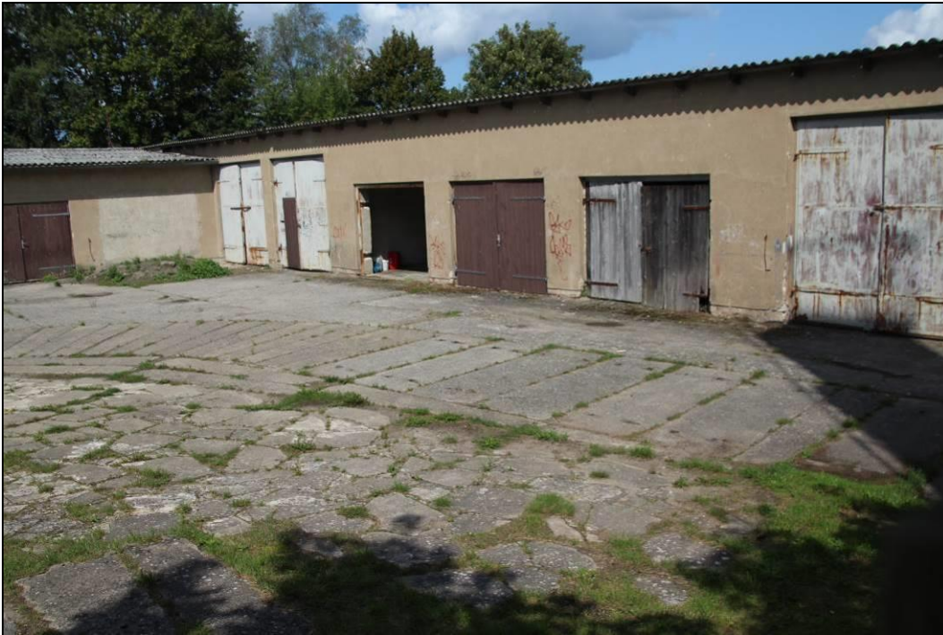
Abbildung 11: Noch teilweise bis Sommer 2020 genutzte Hallen des Gebäudes 2d.
