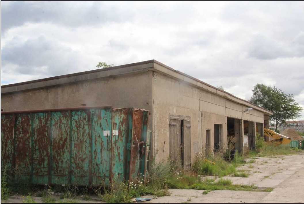
Abbildung 9: Mit Betonelementen gedeckte Halle (Gebäude 1a).
