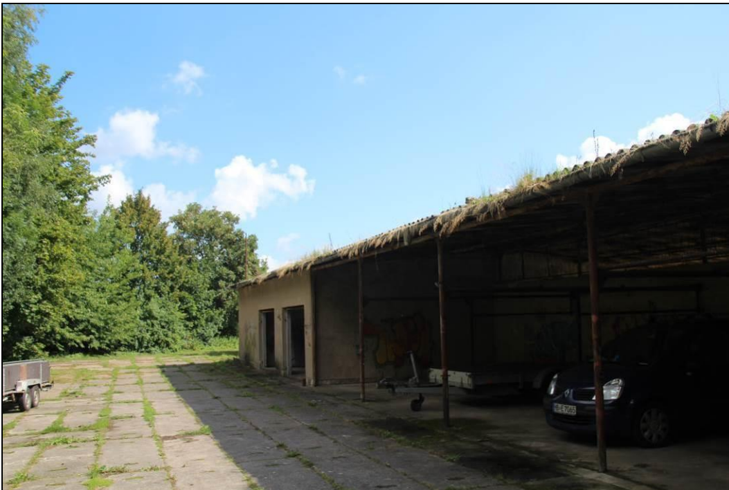
Abbildung 12: Noch teilweise bis Sommer 2020 genutzte Hallen des Gebäudes 2d.
