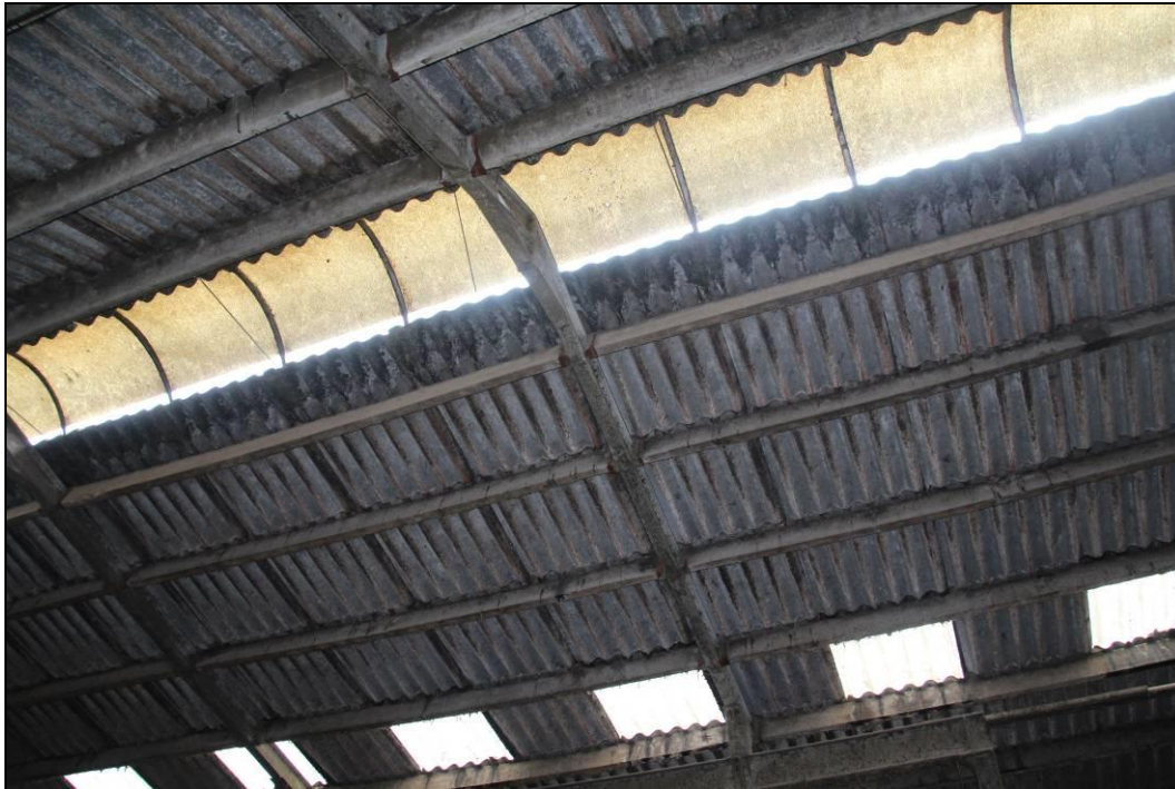
Abbildung 49: In diesem Dachbereich werden die Rauchschwalbennester angebracht.
