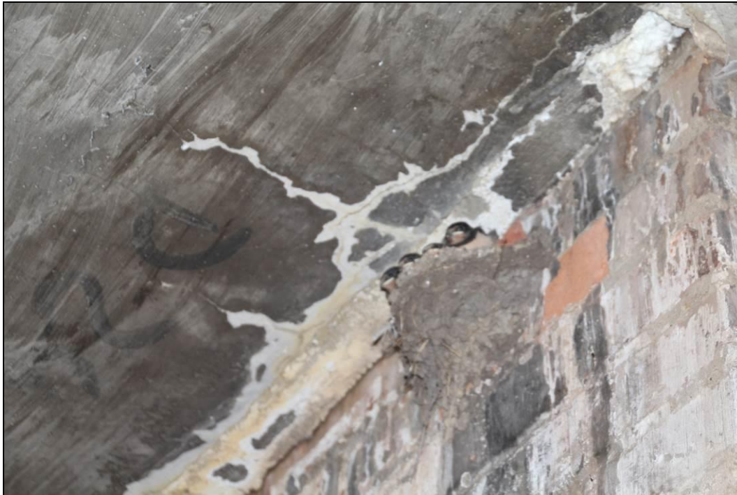
Abbildung 43: Rauchschwalbennest mit Jungtieren im alten Heizhaus der ehemaligen Gärtnerei (Gebäude 5).
