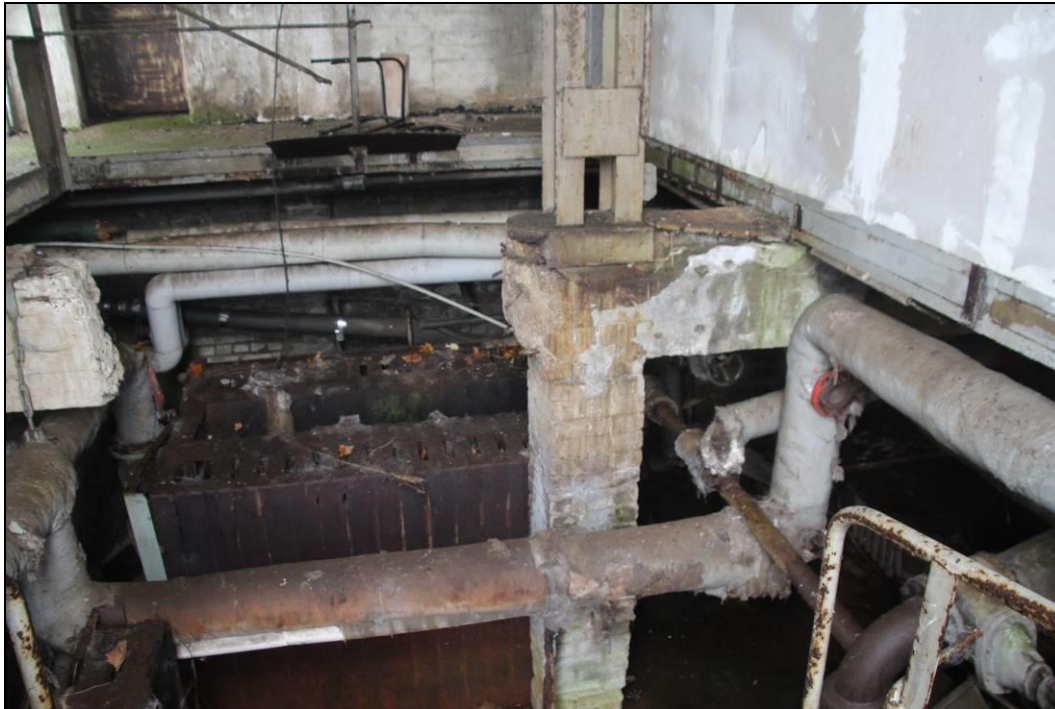
Abbildung 34: Blick vom Erdgeschoss in den Keller des alten Heizhauses der ehemaligen Gärtnerei (17. Februar 2021).
