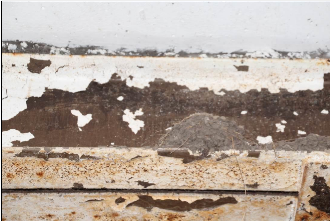
Abbildung 41: Rauchschwalbennest im alten Heizhaus der ehemaligen Gärtnerei (Gebäude 5).
