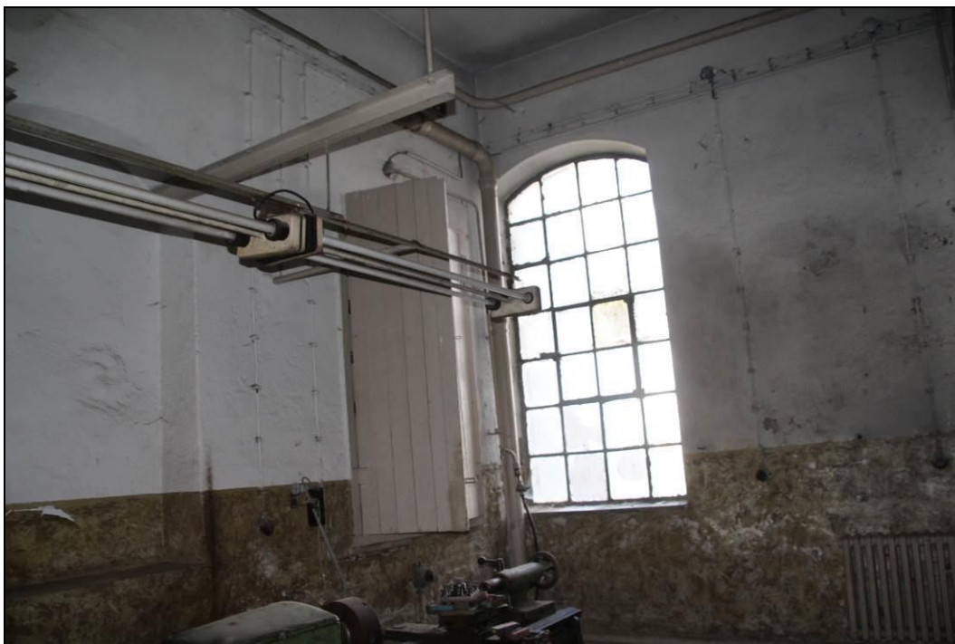
Abbildung 6: Innenansicht des Gebäudes 1b. Im Erdgeschoss befand sich eine Werkstatt.
