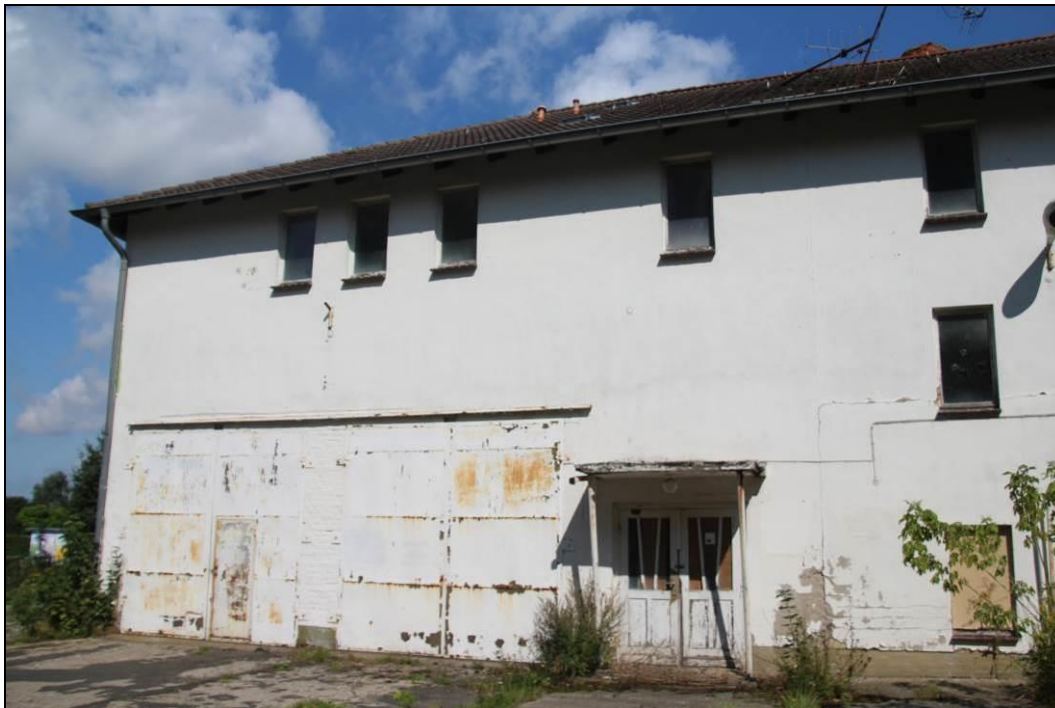
Abbildung 4: Gebäude 1b aus Richtung Süden.
