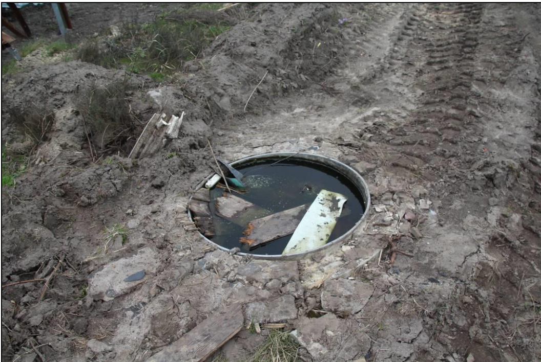
Abbildung 51: Wassertonne im Plangeltungsbereich (18. März 2020).
