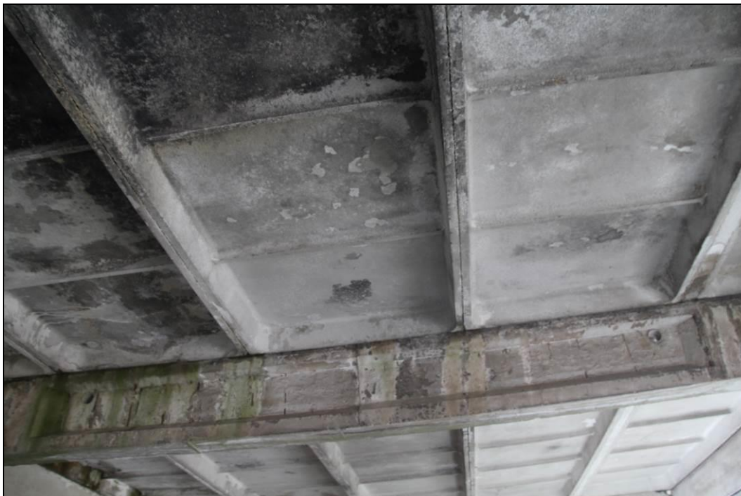
Abbildung 23: Potenziell als Sommerquartier für Pipistrellus -Arten geeignetes Dach aus Betonteilen im Gebäude 1a.
