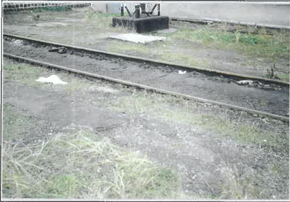
Bild 21: B-001051-045 - ehemalige Heizöltankanlage, Gleis 70
