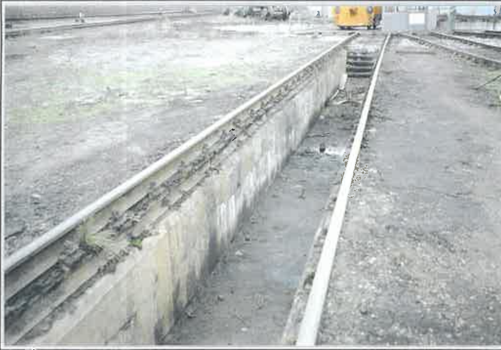
Bild 6: B-001051-046 - Lokhaltstellen vor Lokschuppen 3
