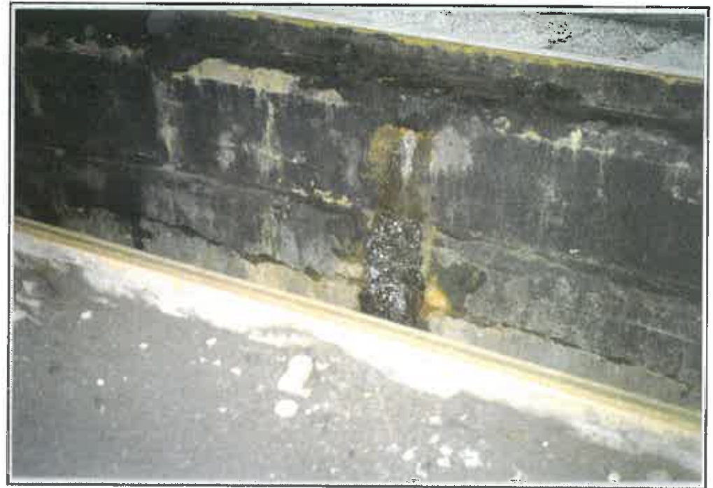
Bild 12: B-001051-049 - Arbeitsgrube, Gleis 57
