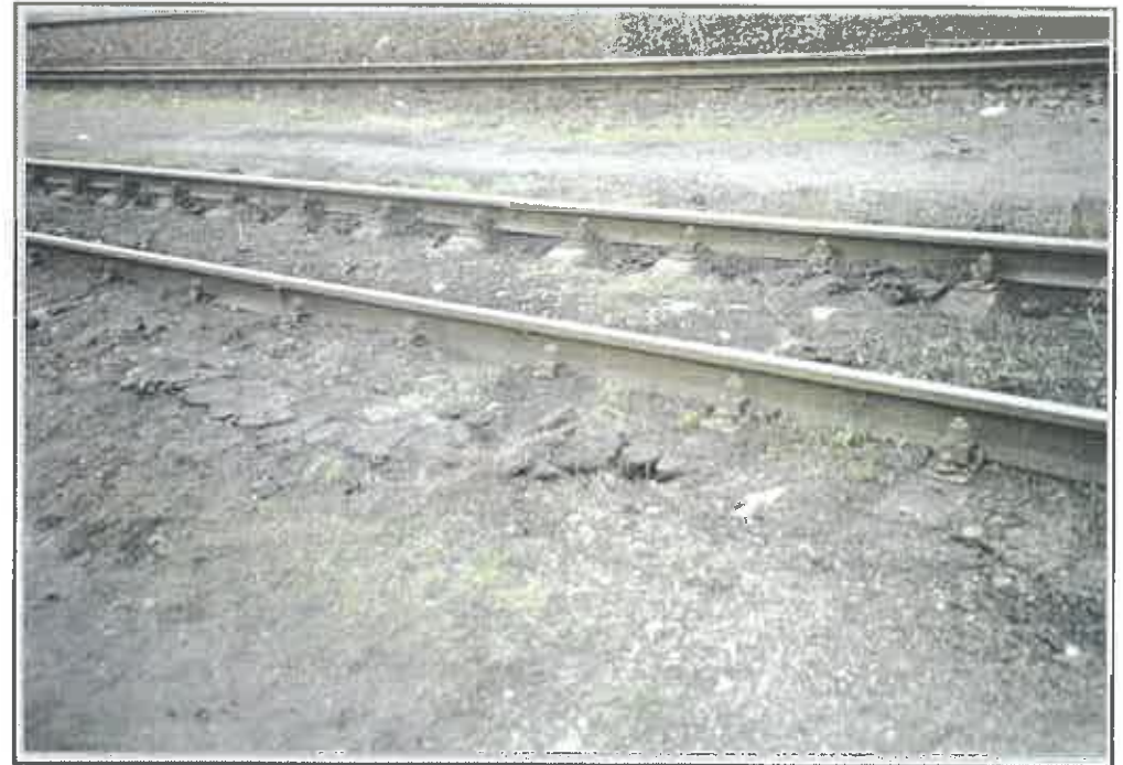
Bild 7: B-001051-046 - Lokhaltstellen vor Lokschuppen 3
