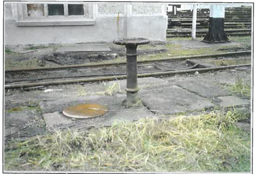
Bild 22: B-001051-045 - ehemalige Heizöltankanlage, Gleis 70
